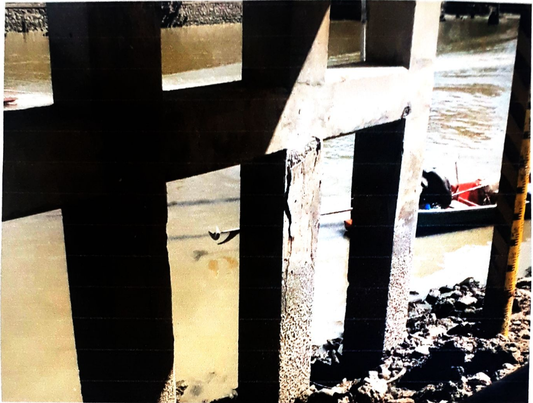
การตรวจสอบโครงสร้างสะพานข้ามแม่น้ำเพชรบุรี บริเวณวัดต้นสน หมู่ที่ ๒ - หมู่ที่ ๗ วันที่ ๒๓ กรกฎาคม ๒๕๖๓
